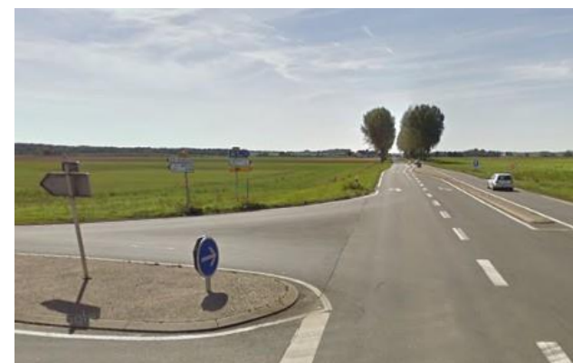
Photo 54 : la RD1017 à hauteur de la RD337
