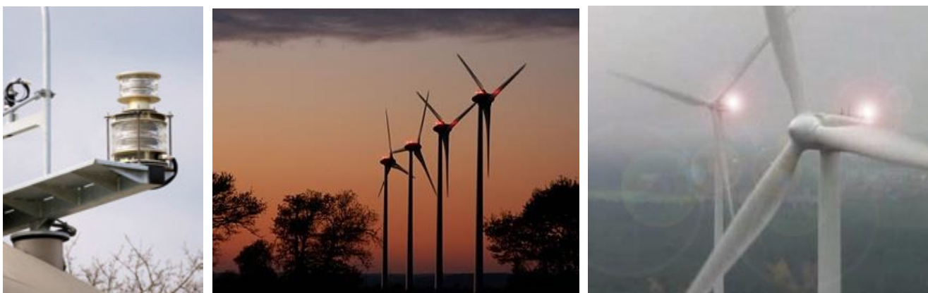
Photo 116 : Balisage d'éoliennes
