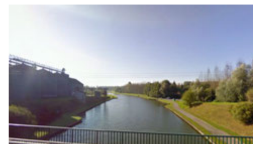
Photo 20 : canal depuis le pont sur la D930
