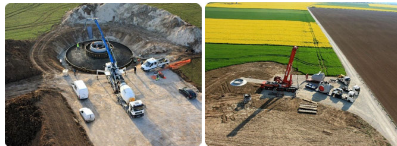
Photo 105 : circulation d'engins lors du chantier de construction de la centrale éolienne du Bois Cheneau (source : VOL-V, LGC © 2009 Double J Photos)
