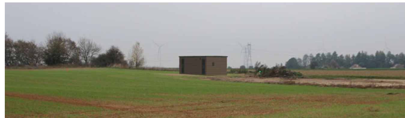
Figure 262 : photomontage du poste de livraison avec bardage bois (point A)
