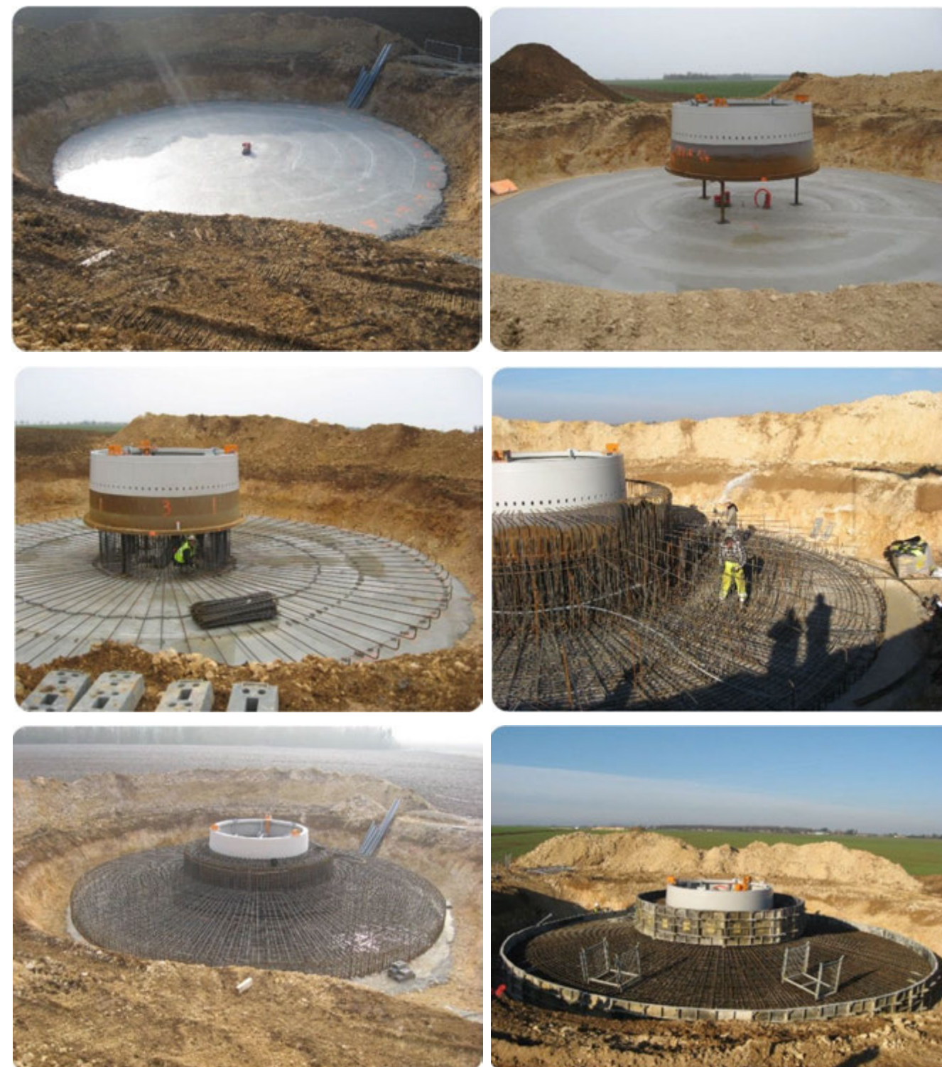
Photo 96 : mise en place des ferrailages – Centrale éolienne des Vingt-Setiers (source : VOL-V)
