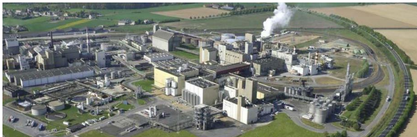
Photo 24 : photo aérienne oblique de la zone d'activité de Nesle
