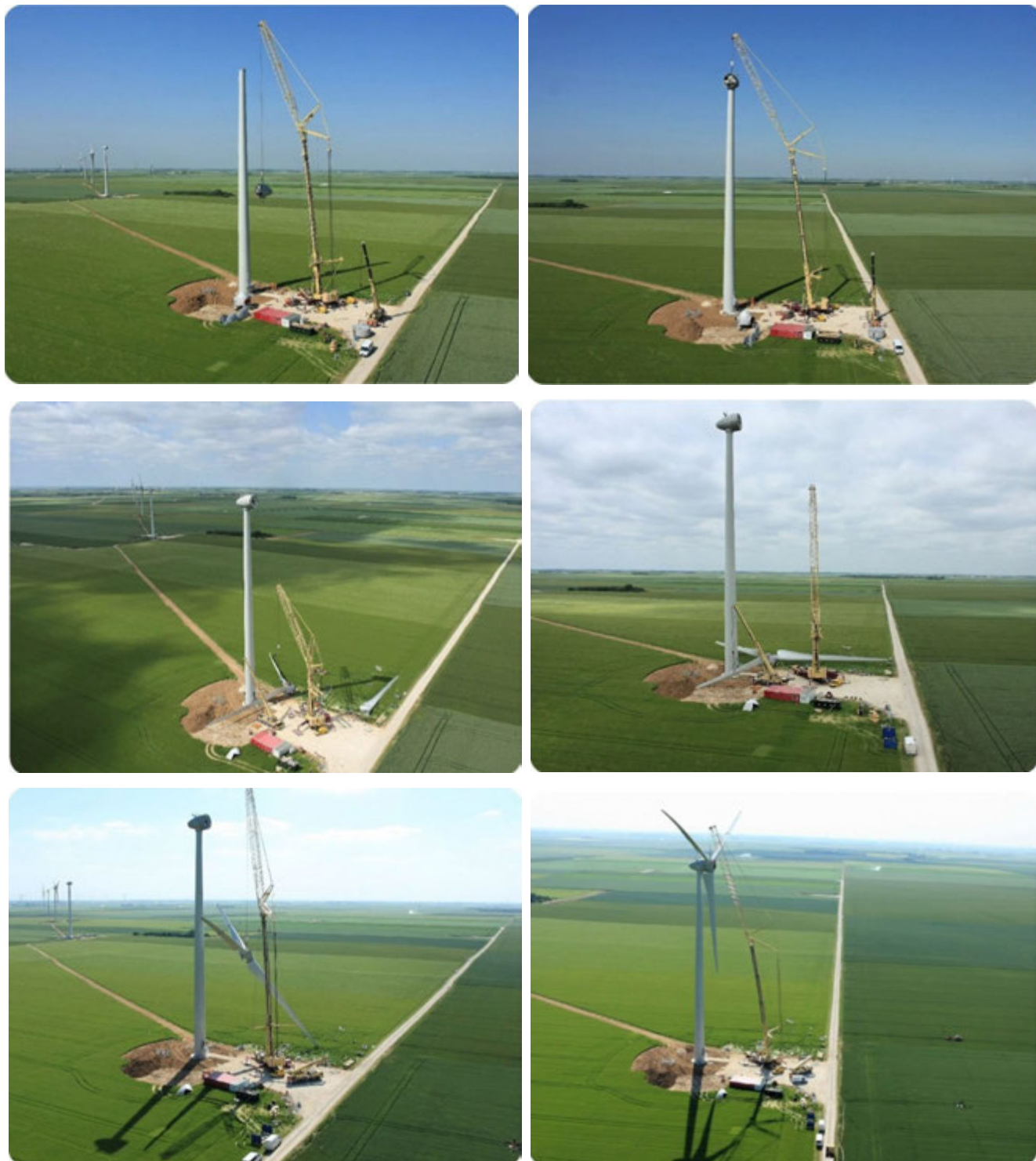
Photo 99 : Levage des machines de la centrale éolienne du Bois Cheneau (source : VOL-V, LGC © 2009 Double J Photos)
