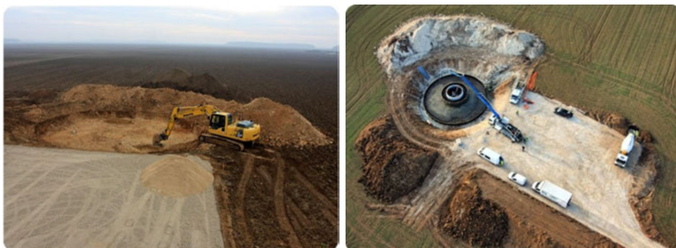
Photo 104 : creusement de la fouille et mise en place d'une fondation de la centrale éolienne du Bois Cheneau (source : VOL-V, LGC © 2009 Double J Photos)
