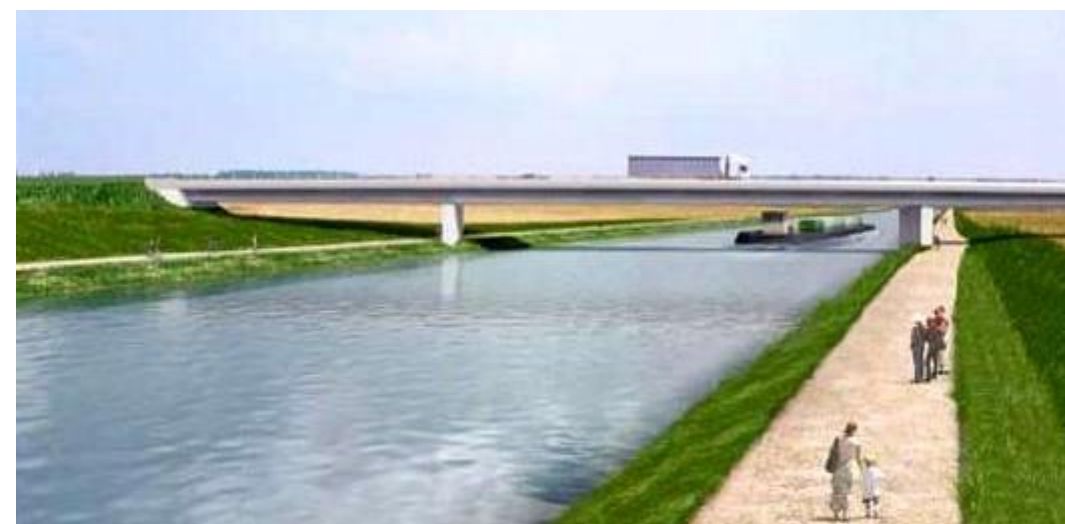
Figure 54 : montage photographique représentant le canal Seine-Nord-Europe
