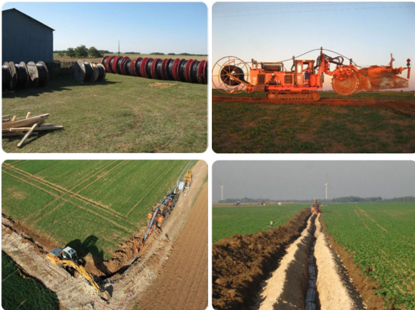
Photo 95 : mise en place des réseaux de la Centrale éolienne du Bois Cheneau (source : VOL-V, LGC © 2009 Double J Photos)
