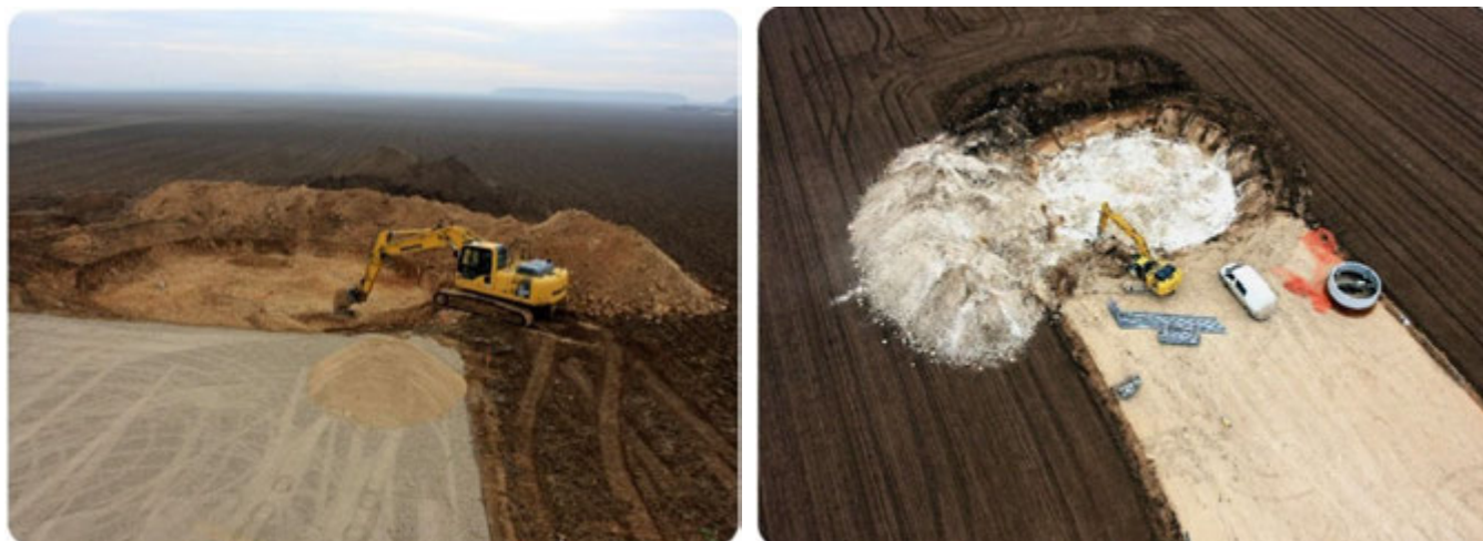
Photo 101 : fouilles des fondations de la centrale éolienne du Bois Cheneau (source : VOL-V, LGC © 2009 Double J Photos)
