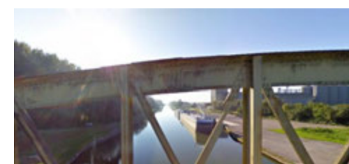
Photo 21 : canal depuis le pont sur la D89
