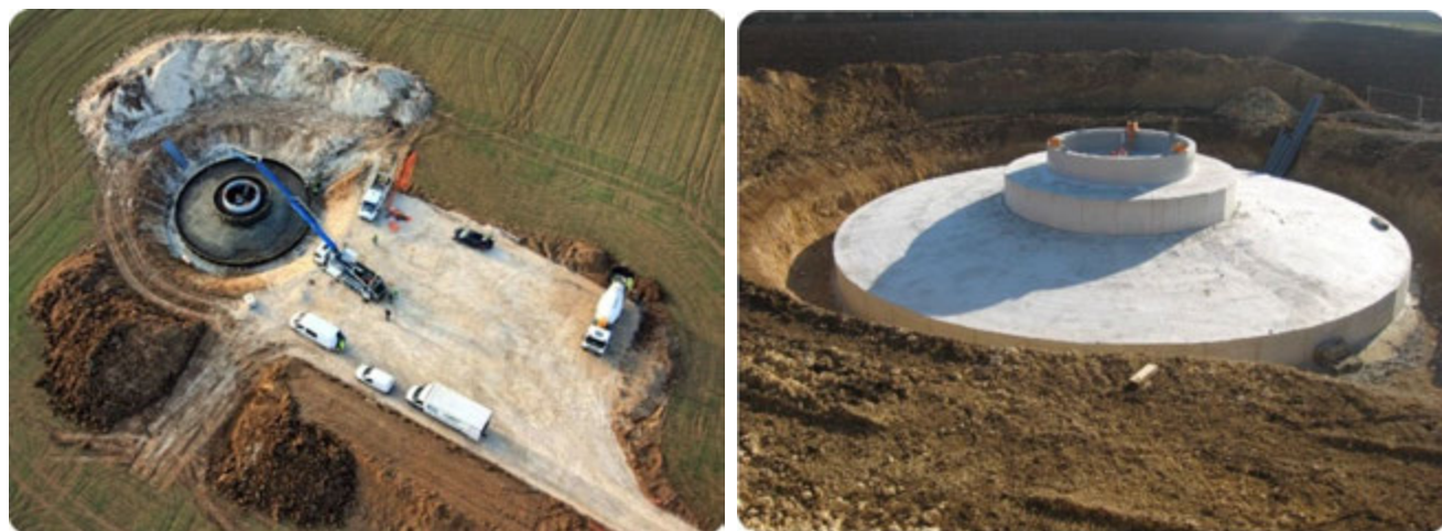
Photo 92 : coulage des fondations de la centrale éolienne du Bois Cheneau (source : VOL-V, LGC © 2009 Double J Photos)
