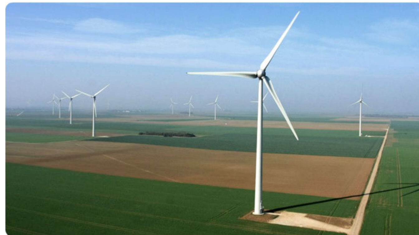
Photo 100 : Centrale éolienne du Bois Cheneau en service (source : VOL-V, LGC © 2009 Double J Photos)
