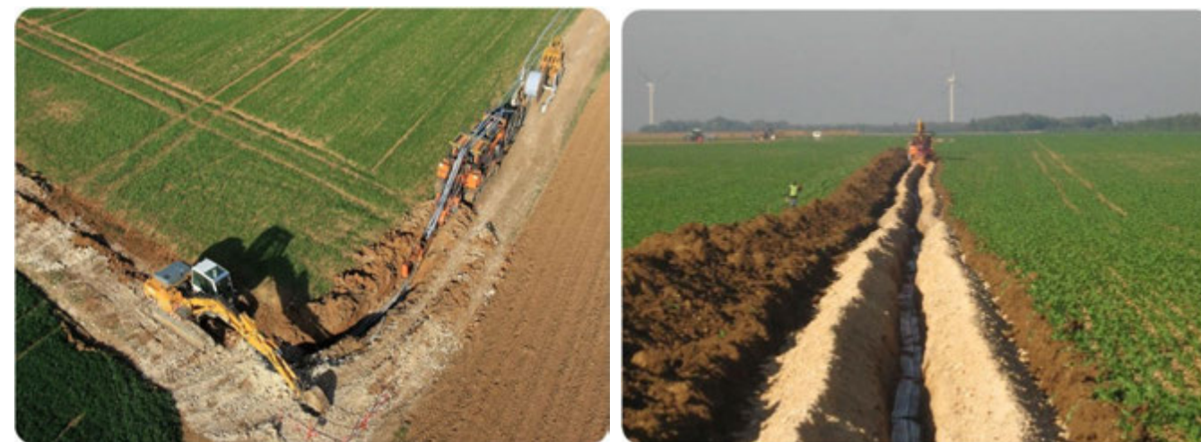
Photo 93 : mise en place des réseaux de la Centrale éolienne du Bois Cheneau (source : VOL-V, LGC © 2009 Double J Photos)
