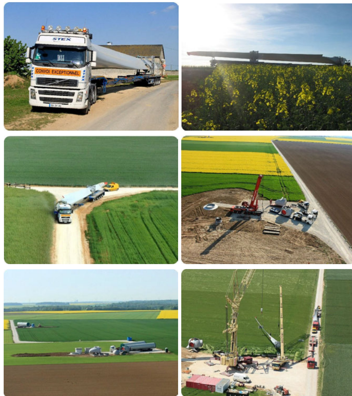
Photo 98 : acheminement des éléments de la centrale éolienne des Vingt-Setiers (source : VOL-V, ©2011 Double J Photos)
