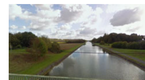
Photo 22 : canal depuis le pont sur la D241
