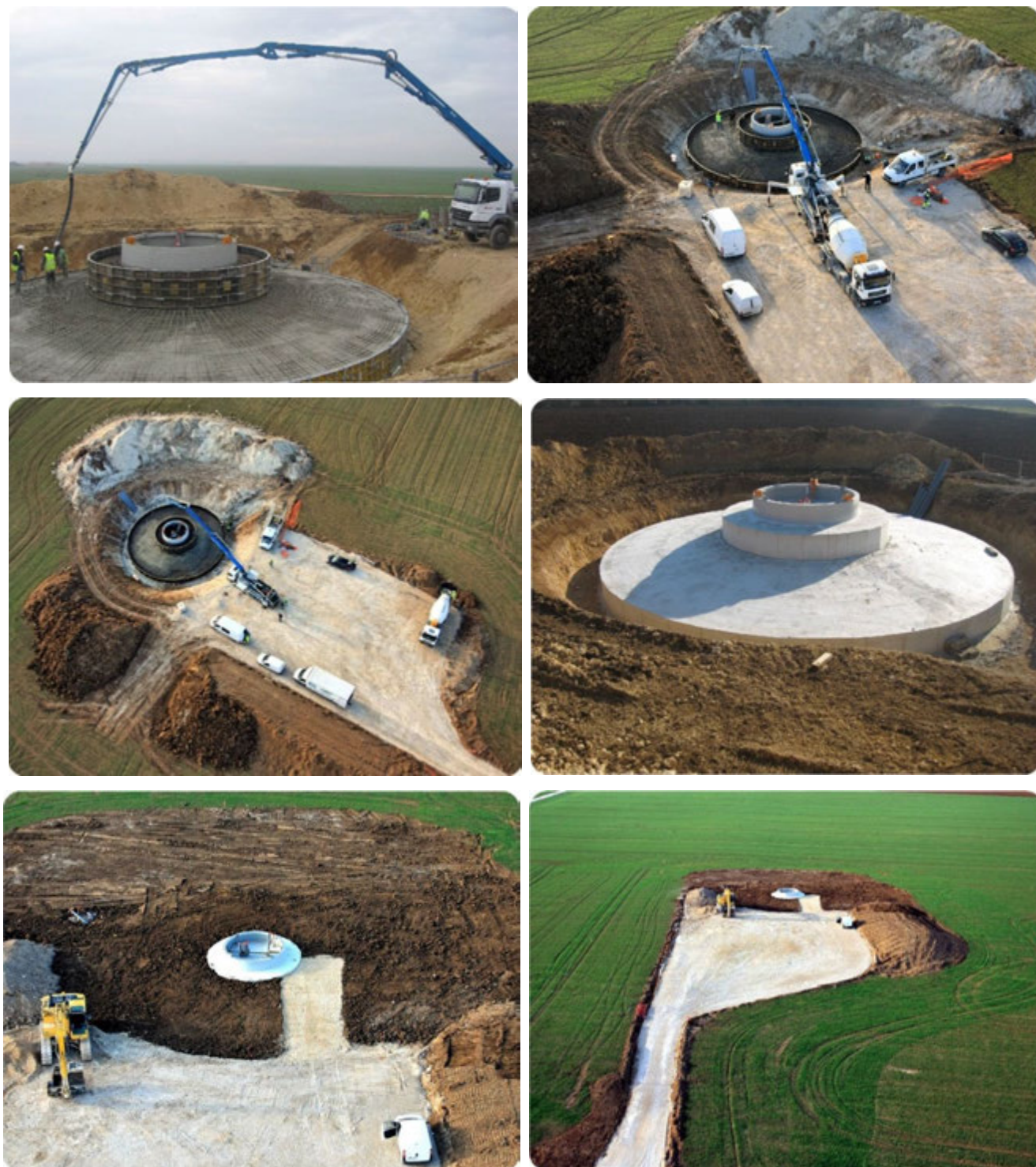
Photo 97 : coulage des fondations de la centrale éolienne du Bois Cheneau (source : VOL-V, LGC © 2009 Double J Photos)
