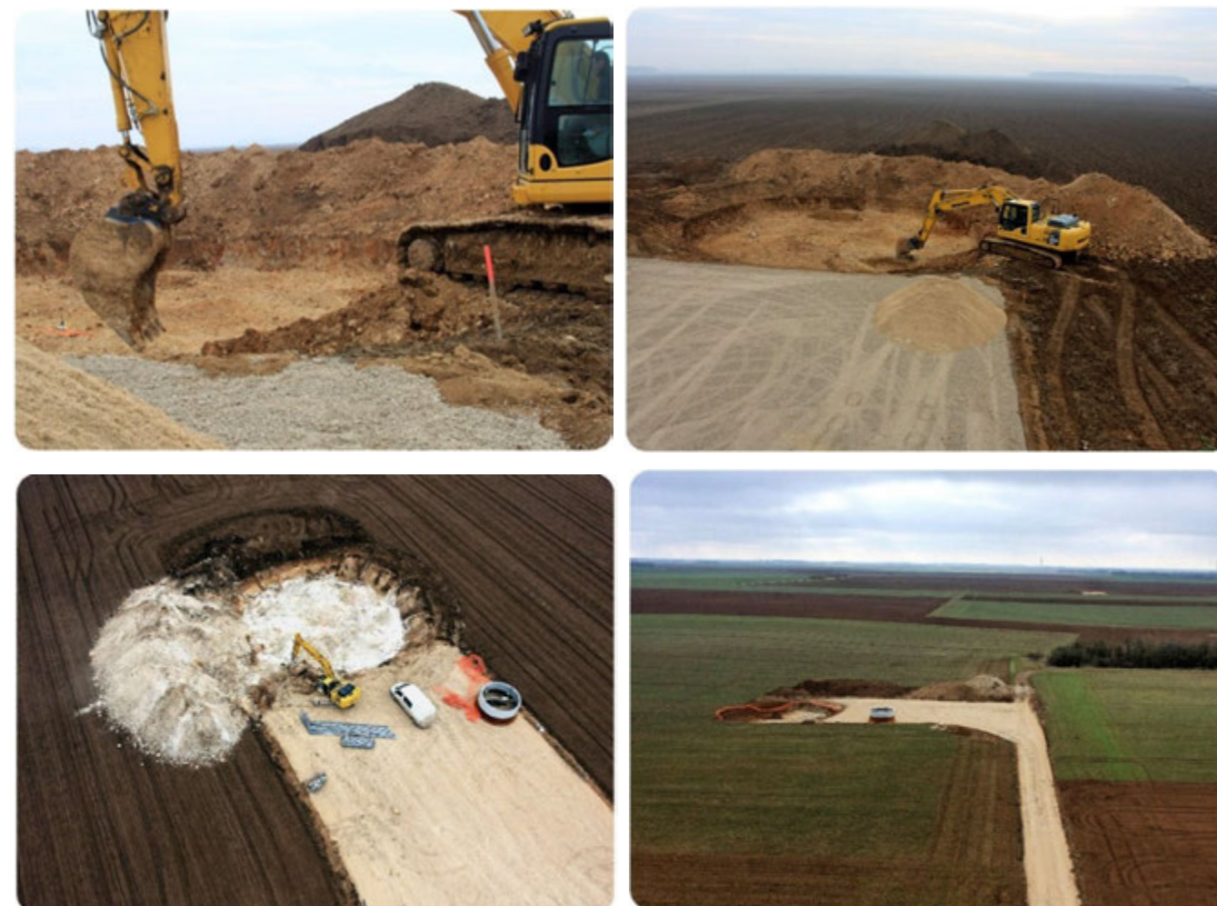
Photo 94 : fouilles des fondations de la centrale éolienne du Bois Cheneau (source : VOL-V, LGC © 2009 Double J Photos)
