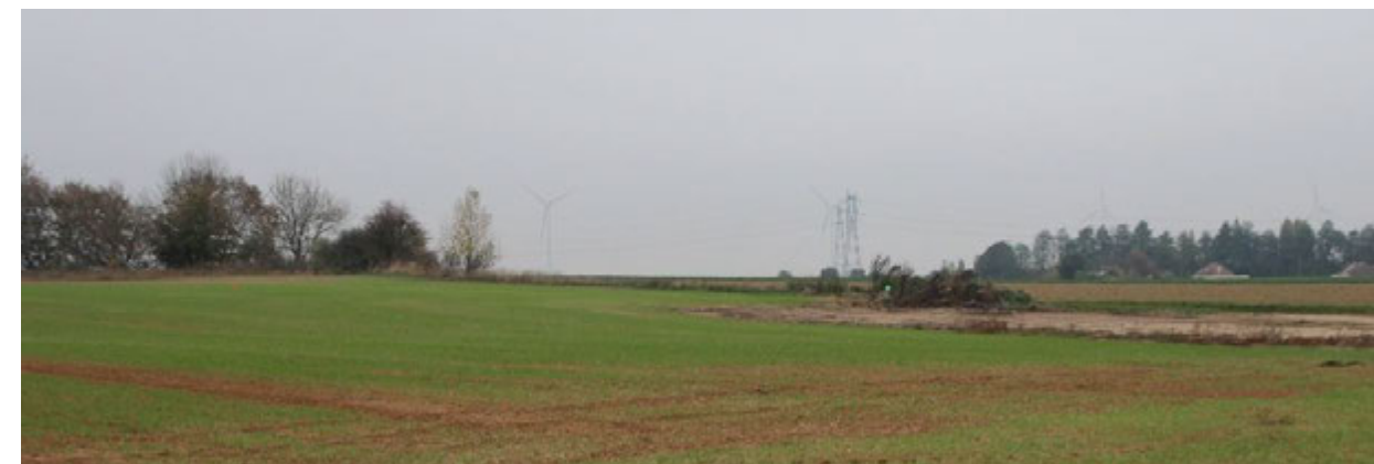
Photo 106 : secteur d'implantation du poste de livraison électrique
