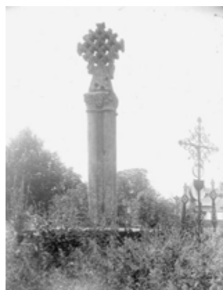
Photo 75 : croix en pierre de Fresnoy-lès-Roye (basse Mérimée)
