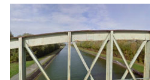
Photo 23 : canal depuis le pont sur la D154
