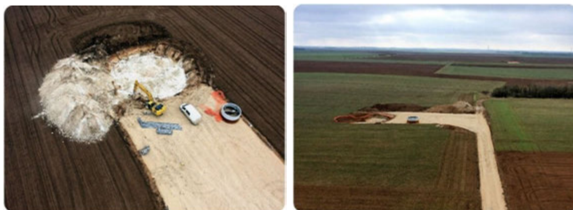
Photo 91 : plateformes et fouilles des fondations de la centrale éolienne du Bois Cheneau (source : VOL-V, LGC © 2009 Double J Photos)
